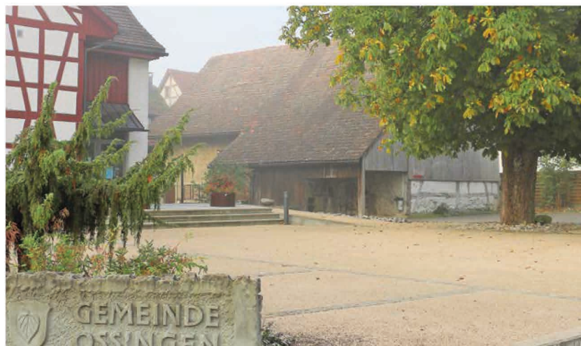
In den 90er-Jahren wollte man die Küblerscheune (hinten) abreißen. Nun dürfte sie das Herzstück einer Arealaufwertung werden.
